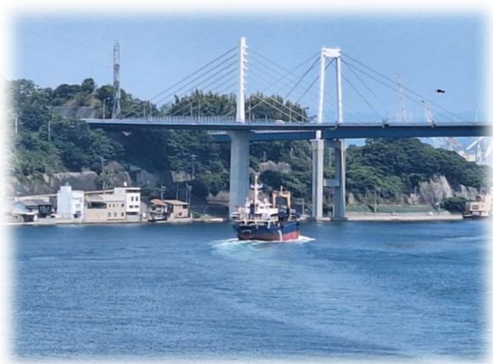
屋上からの風景
